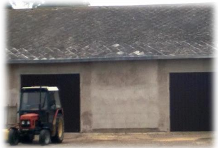
Rysunek 1. Wyroby azbestowo-cementowe: na górze z lewej- płyty faliste, na dole po prawej- płyty płaskie (źródło: materiały własne).
