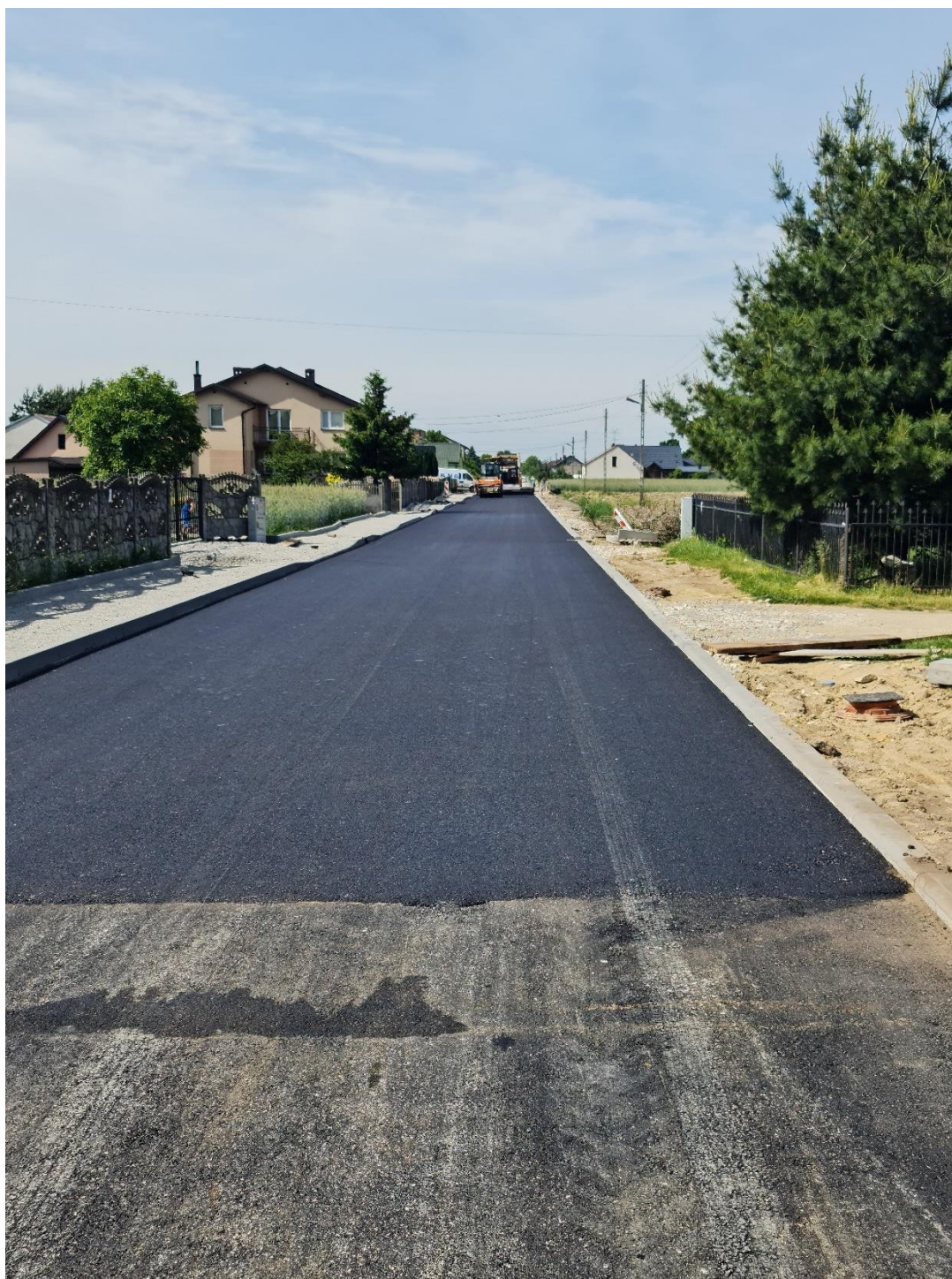
Zdjęcie 9 Przebudowa ulicy Dębowej w Miedźnie (warstwa wiążąca)
