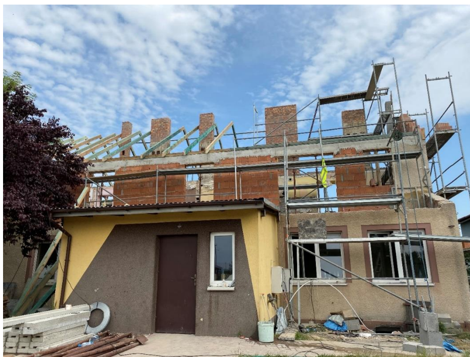
Zdjęcie 13 Przebudowa budynku byłej Szkoły Podstawowej w Izbiskach
