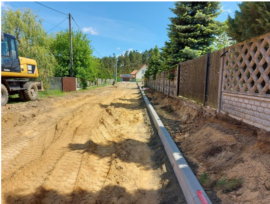
Zdjęcie 4 Przebudowa ul. Słonecznej w Ostrowach nad Okszą
