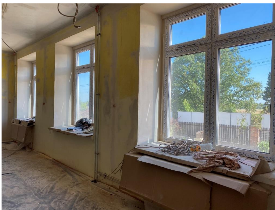
Zdjęcie 15 Termomodernizacja ZSP w Mokrej
