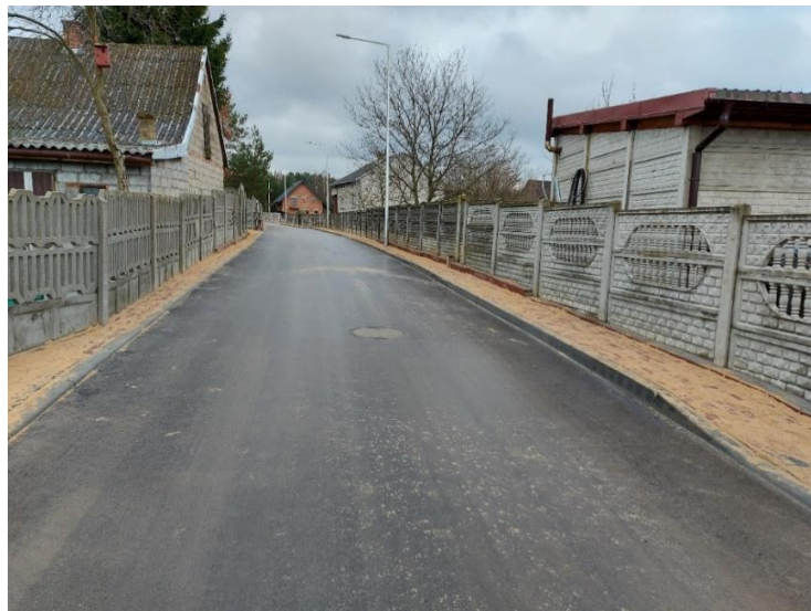
Zdjęcie 2 Przebudowa ulicy Leśnej w Ostrowach nad Okszą
