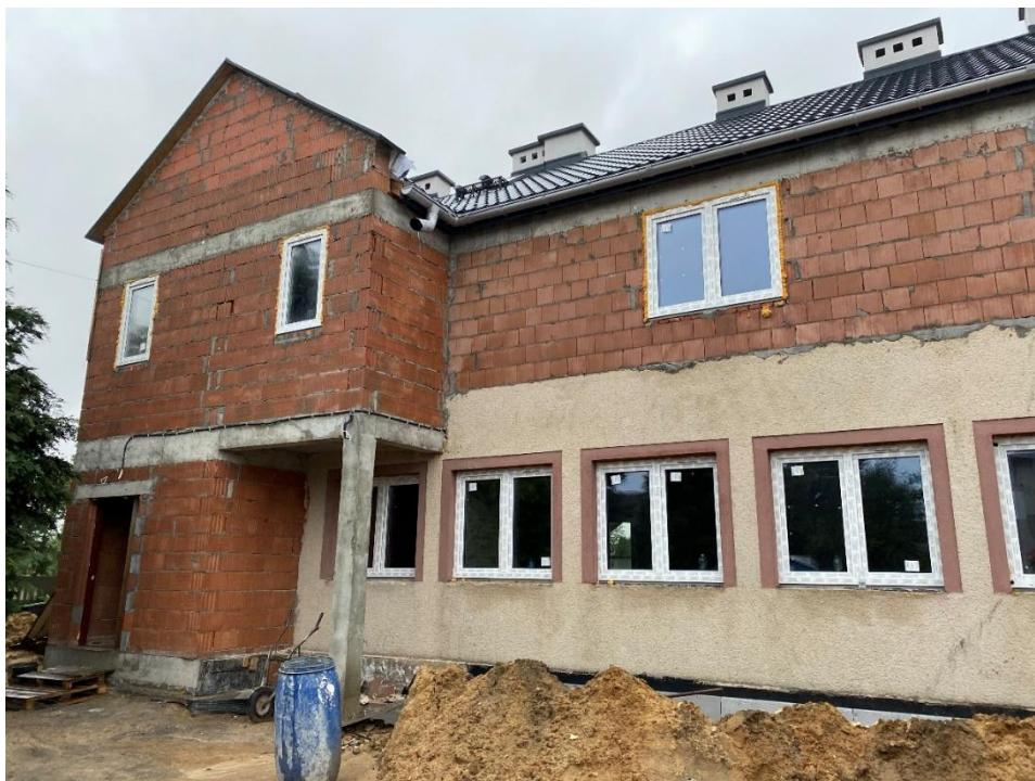
Zdjęcie 14 Przebudowa budynku byłej Szkoły Podstawowej w Izbiskach
