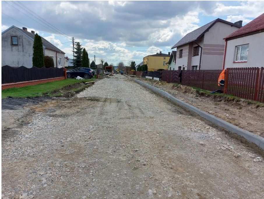
Zdjęcie 3 Inwestycja przebudowy ul. Dębowej w Miedźnie
