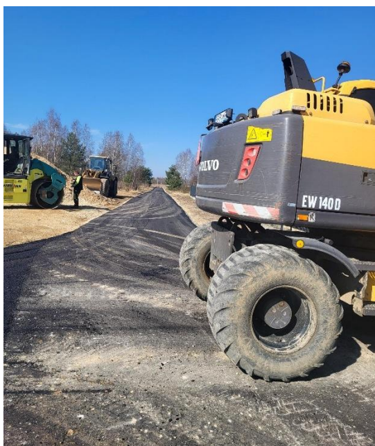
Zdjęcie 90 Budowa ul. Kleśnianej w Ostrowach nad Okszą
