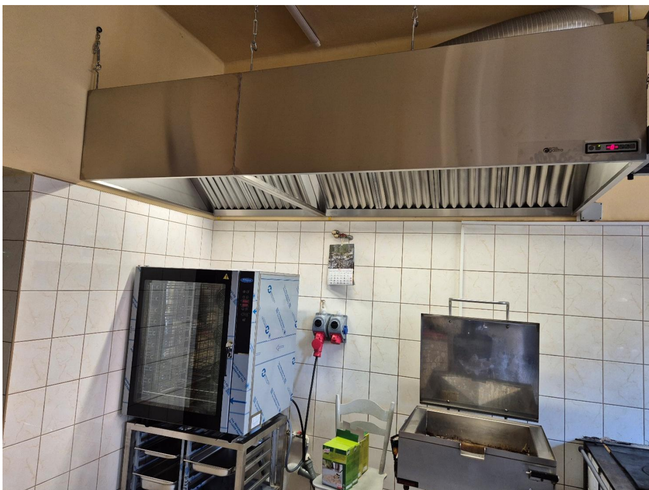
Zdjęcie 10 Wymiana okapu wentylacyjnego – przedszkole ZSP Miedźno
