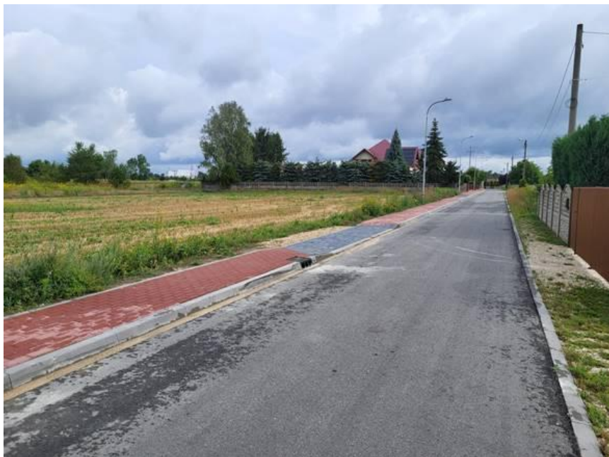
Zdjęcie 93 Budowa chodnika na ul. Ogrodowej w Ostrowach nad Okszą
