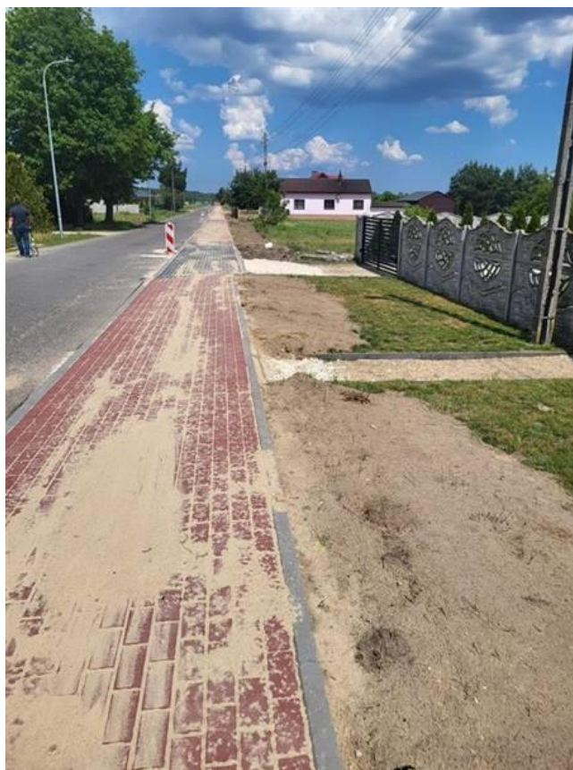
Zdjęcie 94 Budowa chodnika na ul. Władysława Jagiełły w Miedźnie
