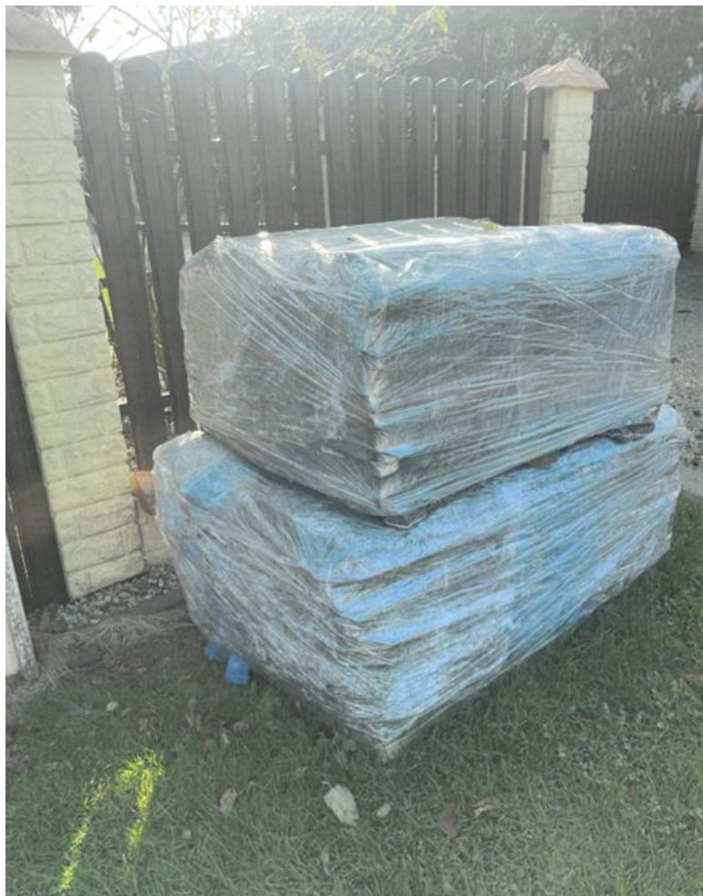
Zdjęcie 3 Zabezpieczony i przygotowany do odbioru azbest.
