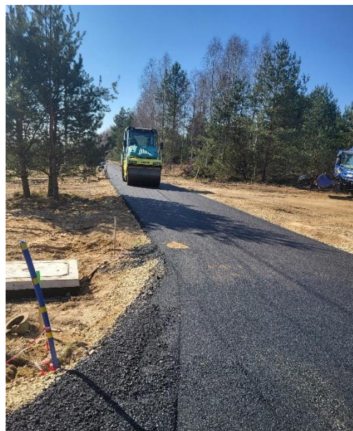
Zdjęcie 91 Budowa ul. Ogrodowej w Ostrowach nad Okszą
