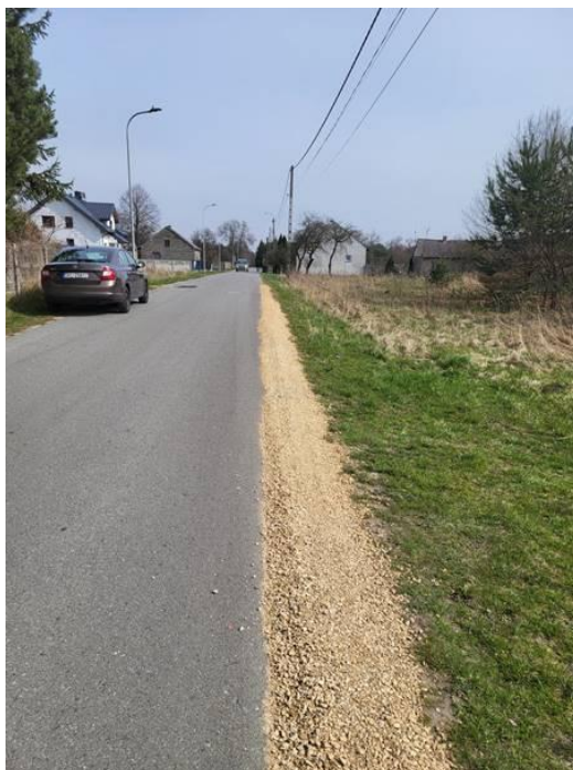
Zdjęcie 97 Bieżąca naprawa w ramach utrzymania dróg w miejscowości Izbiska
