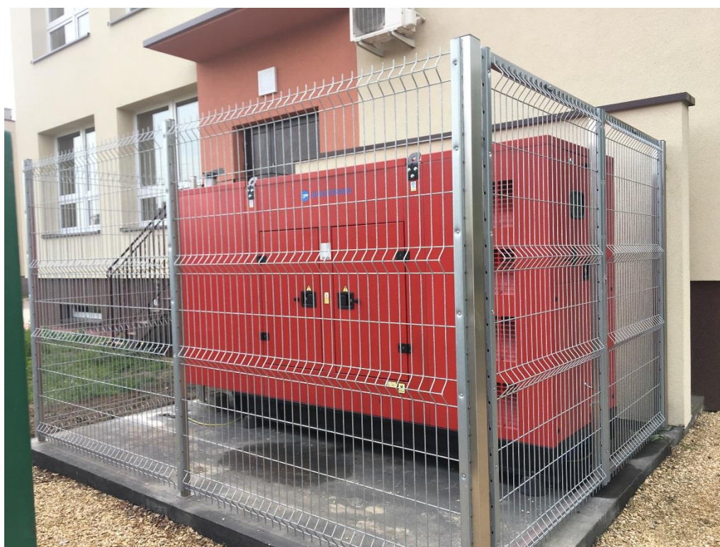
Rysunek 8 Agregat prądowłrczy przy ZSP Miedźno
