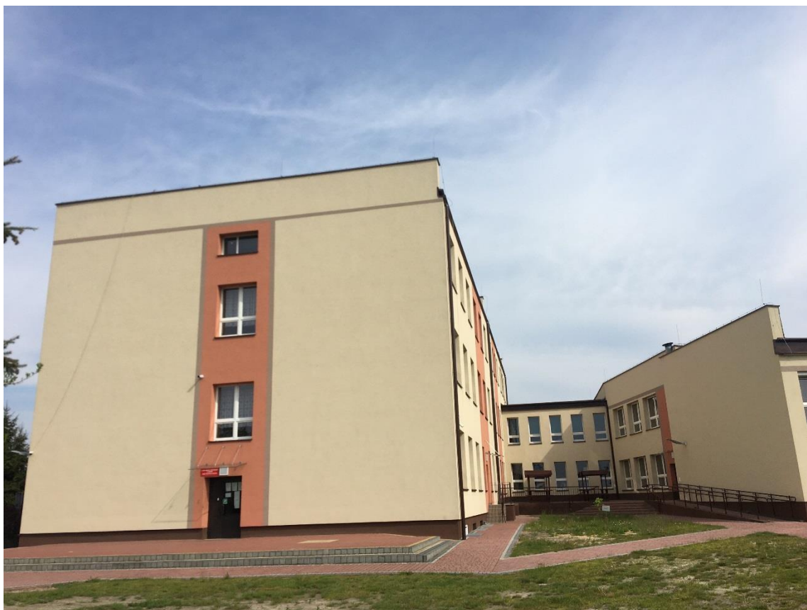
Rysunek 11 Termomodernizacja budynku ZSP Miedźno
