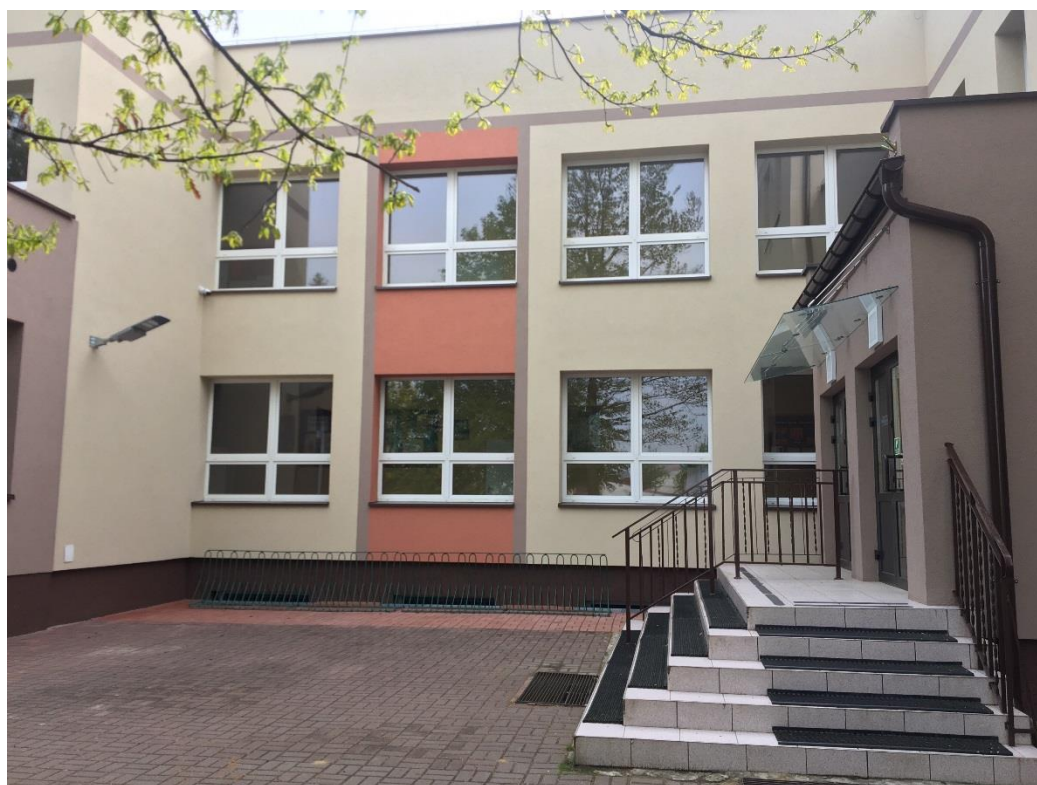
Rysunek 10 Termomodernizacja budynku ZSP Miedźno
