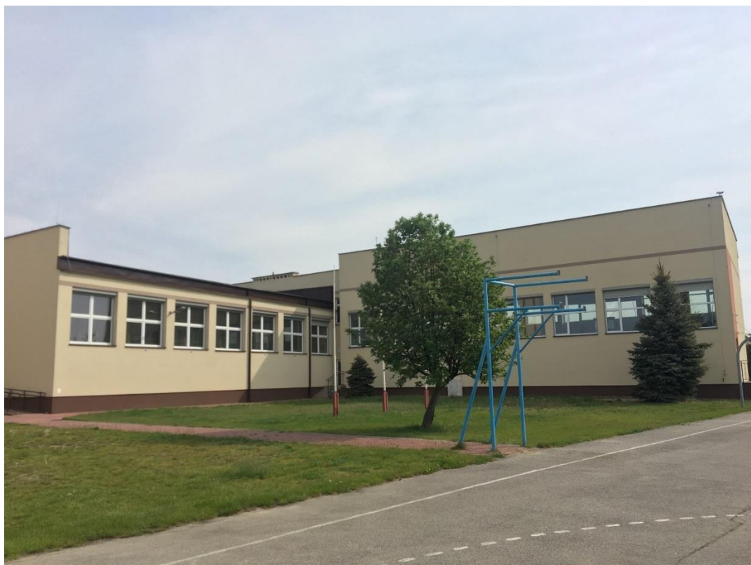
Rysunek 9 Termomodernizacja budynku ZSP Miedźno
