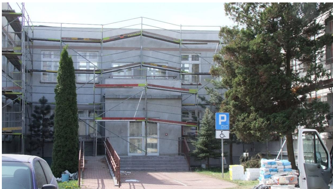
Rysunek 6 Inwestycja termomodernizacji ZSP Miedźno - prace remontowe
