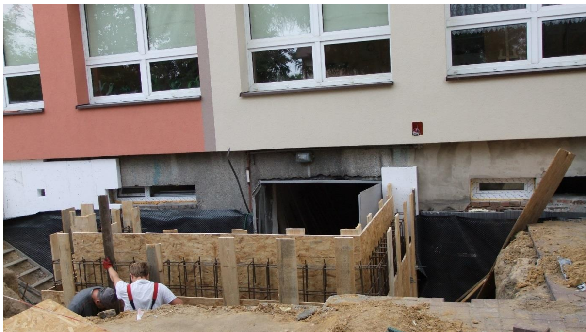
Rysunek 7 Inwestycja termomodernizacji ZSP Miedźno - prace przy kotłowni
